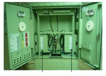
Left-end optical module Right-end optical module
